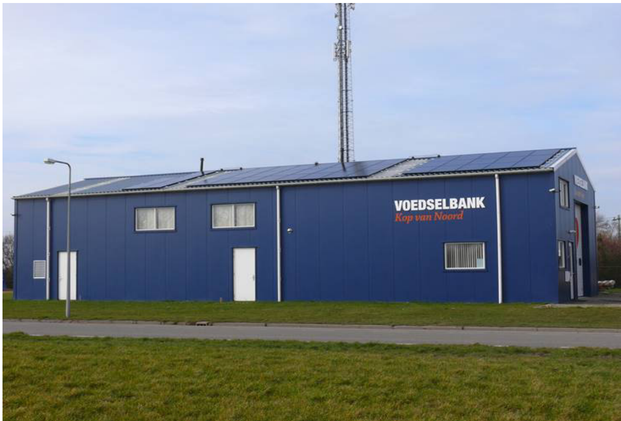
Het dak ligt vol met 88 zonnepanelen.
