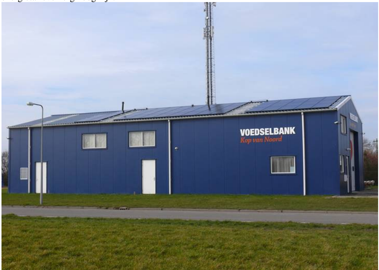
Het dak ligt bijna vol met zonnepanelen
