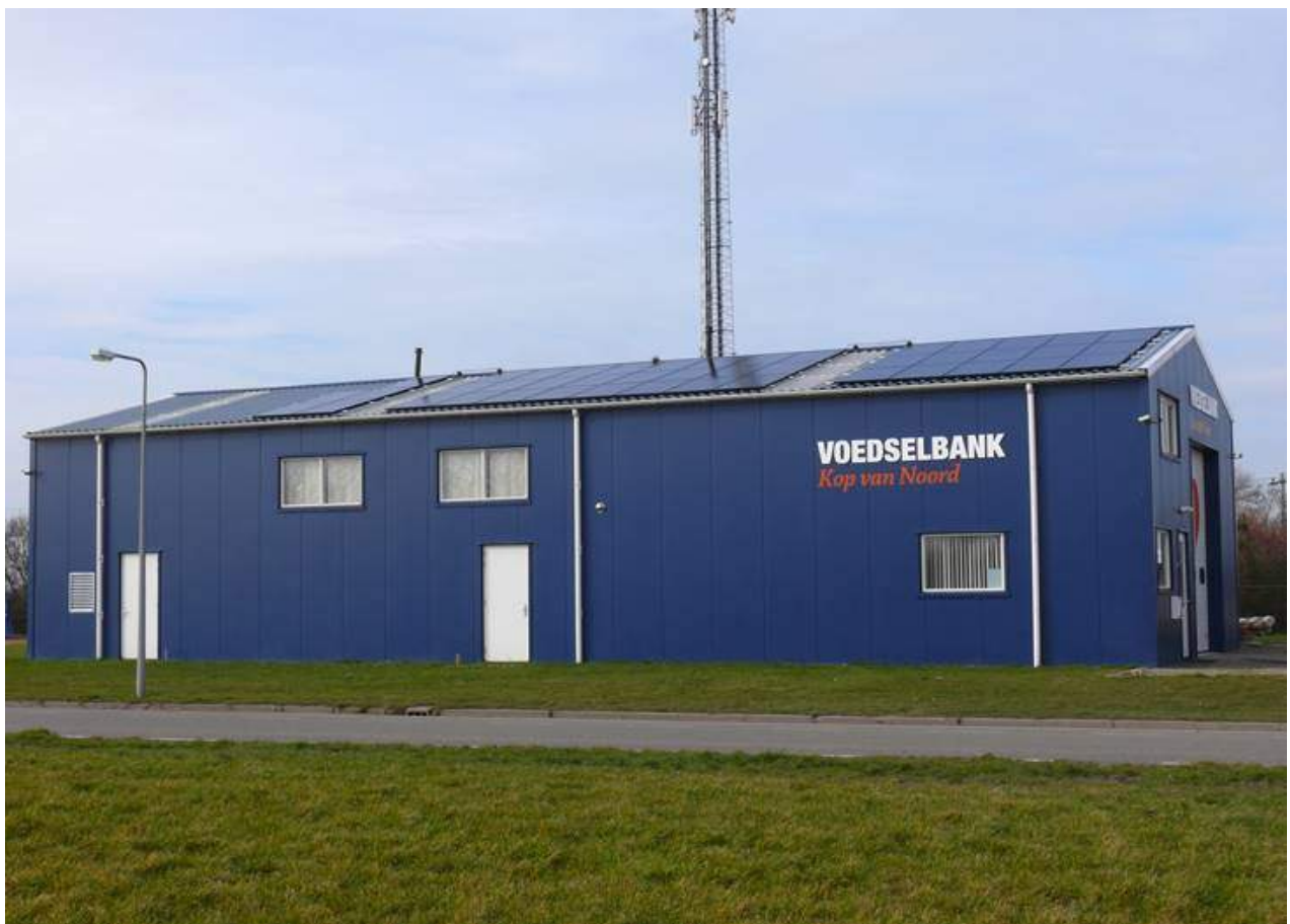
Het dak ligt bijna vol met zonnepanelen
